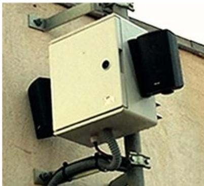
Dispositivo de megafonía sobre IP para sonorización de altas prestaciones, conectividad inalámbrica o cable (FO), con la posibilidad de integrar diferentes sensores, medio ambiente, servicio Wifi, cámaras inteligentes, punto SOS y baliza LED.
